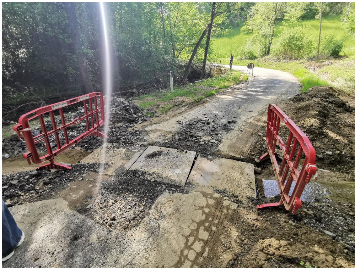
Attraversamento temporaneo creato per il deflusso delle acque. A sinistra corre il Rio SantaFedè.
