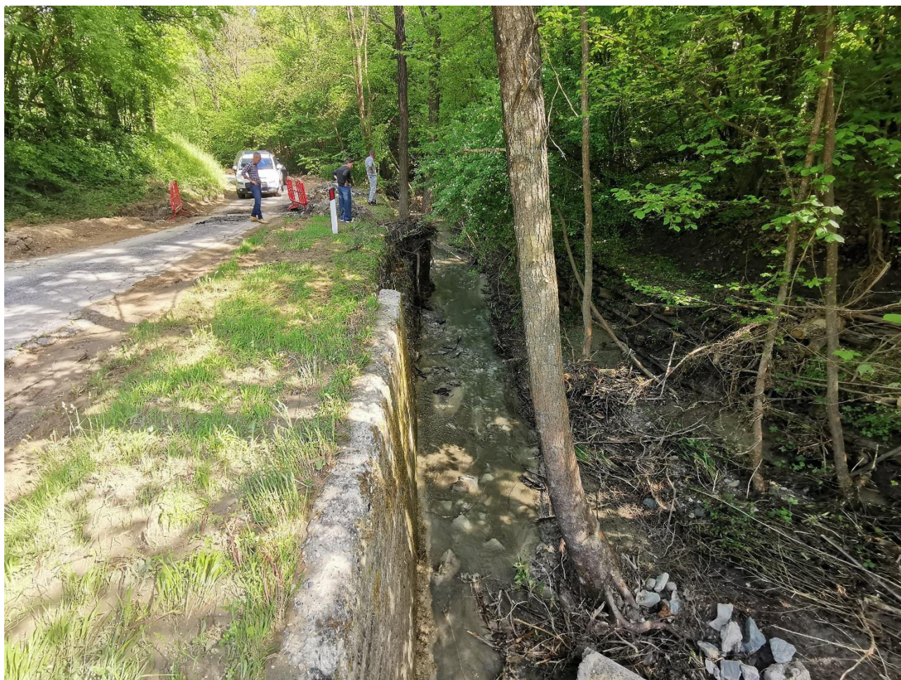
Vista da monte verso valle dell'alveo del Rio Santafede. Si osservi la sponda sinistra prima in muro in c.a. e poi in gabbioni in pietra.
