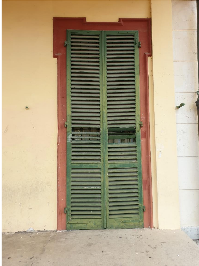
Foto 14 – Particolare gelosia oscurante (porta-finestra)
