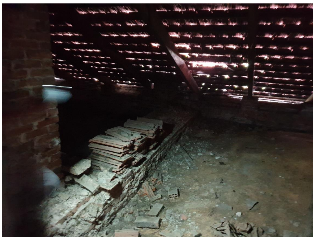
Foto 10 – Sottotetto con macerie da rimuovere e coibentare
