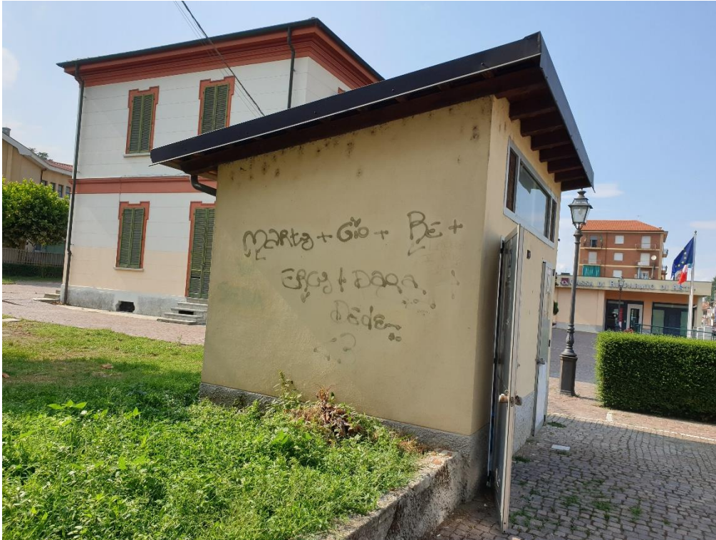
Foto 7 – Zona di passaggio nuova linea gas metano
