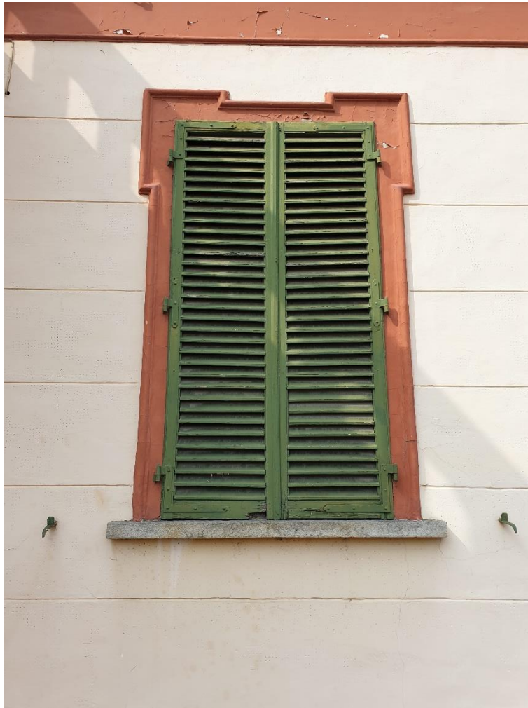
Foto 13 – Particolare gelosia oscurante (finestra)
