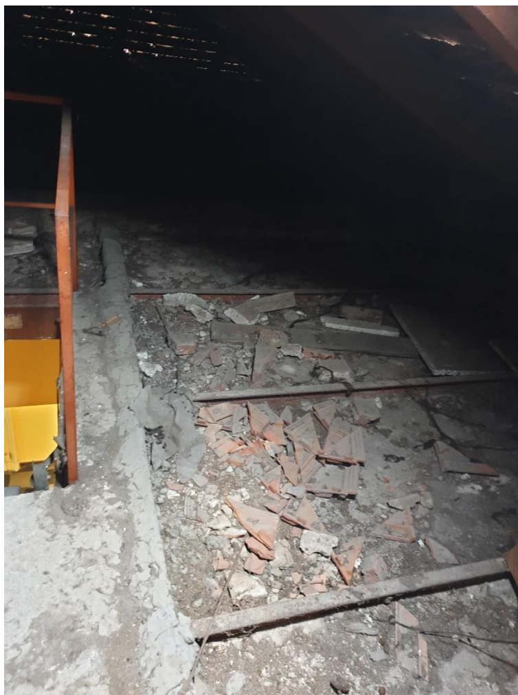
Foto 9 – Sottotetto con macerie da rimuovere e coibentare
