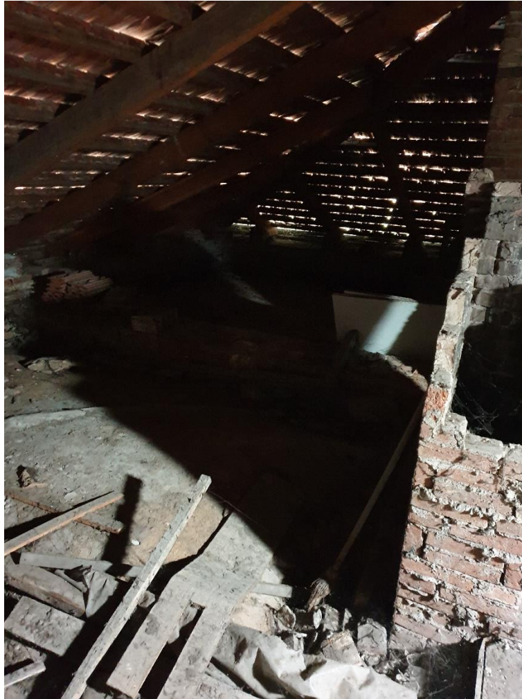
Foto 11 – Sottotetto con macerie da rimuovere e coibentare
