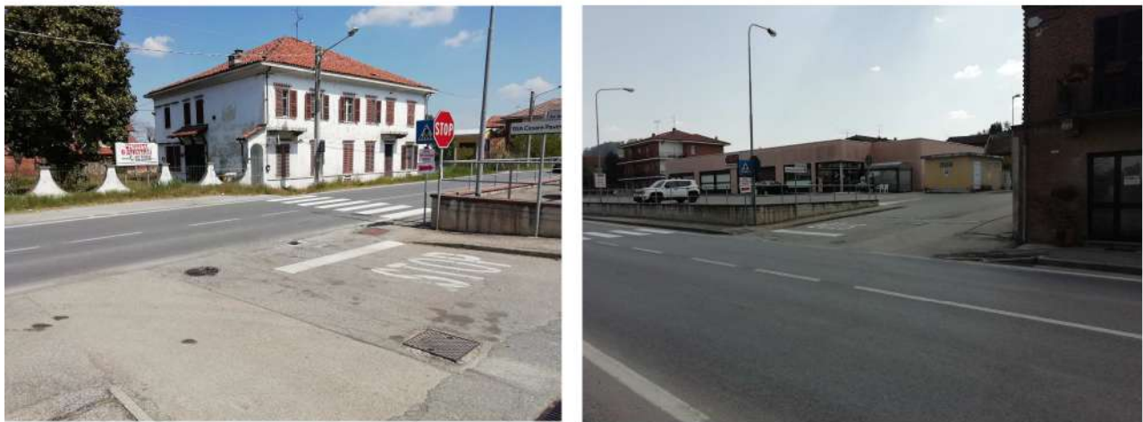
Intervento A: SP 590 in prossimità dell'intersezione con Via Don Carlo Mussano
