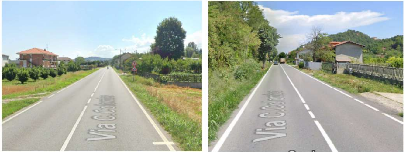
Intervento C: a sx SP 590 direzione Asti in prossimità dell'intersezione con Via Casa Ostino (intervento C1) A dx SP590 direzione Torino in prossimità dell'intersezione con Via Roccabauda (intervento C2)
