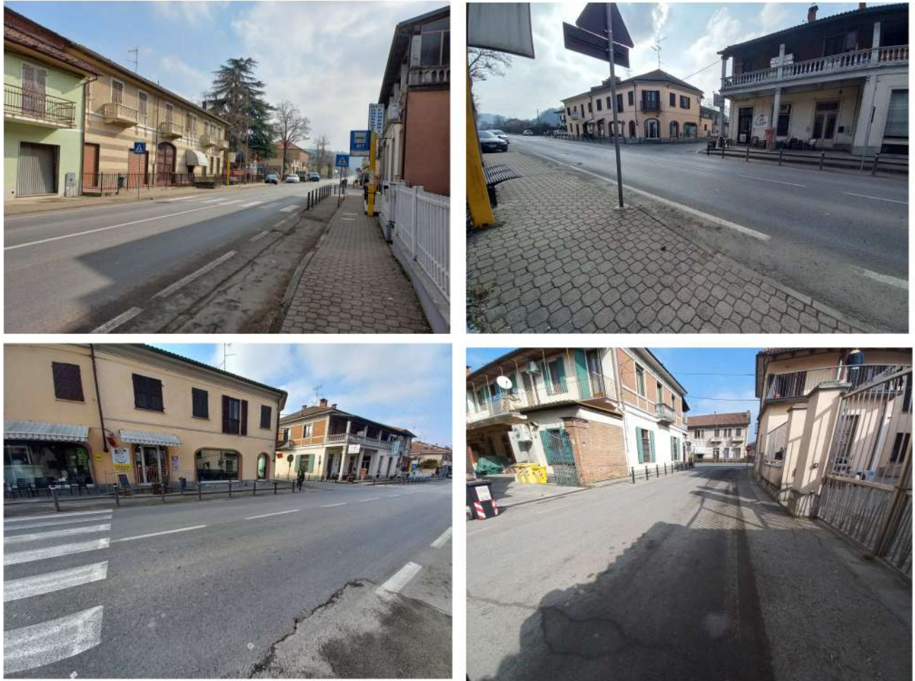
Intervento B: SP 590 in prossimità dell'intersezione con Via Santa Fede (SP108)
